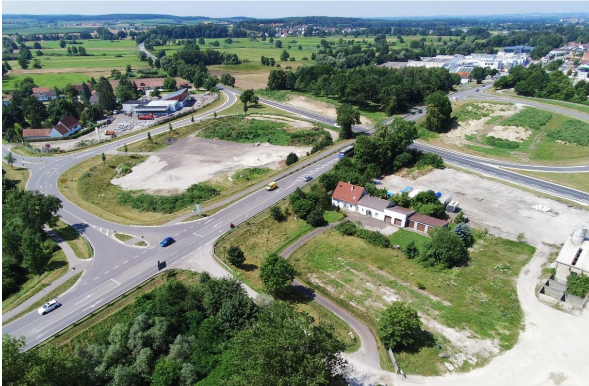
Foto 2 Direkt an der Staatsstraße 2144 und an der Auffahrt zur B16 gelegen, nur wenige Kilometer von der A93 entfernt – perfekte Bedingungen für die Brauereilogistik. Die Zufahrt zum Logistikzentrum könnte künftig durch einen Kreisverkehr geregelt werden, der zugleich die bereits länger bestehenden Verkehrsprobleme an der Staatsstraße lösen würde. (Foto: Brauerei zum Kuchlbauer GmbH & Co KG)
